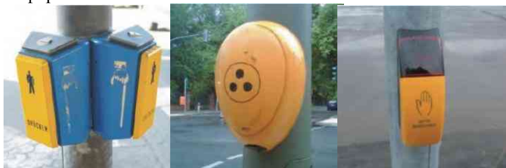
Рисунок 50 – Пример осязательного сигнала пешеходного перехода
