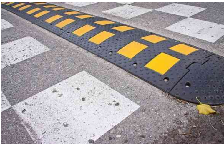
Рисунок 41 – Пример исполнения искусственной неровности сборно-разборной конструкции
